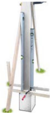
**Zum Einbetonieren (2):** Befüllen Sie alle Löcher mit Beton und stellen Sie den Pfosten hinein. Aufpassen! Den Pfosten nicht exakt bis auf den Boden stellen (circa 50 cm tief) und fixieren.
